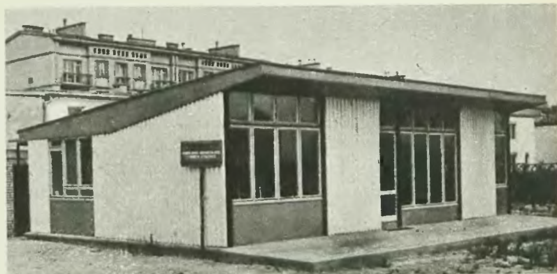
Na Bielanych postawiono również domek doświadczalny z tworzyw sztucznych, eliminując z konstrukcji i wyposażenia mat. deficytowe.
