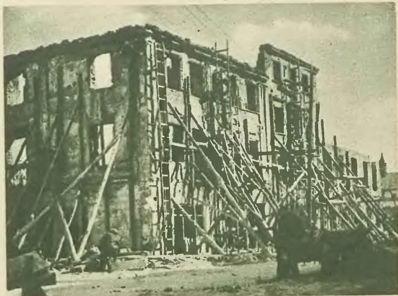
Zabezpieczenie jednej z zabytkowych kamieniczek Nowego Miasta.
