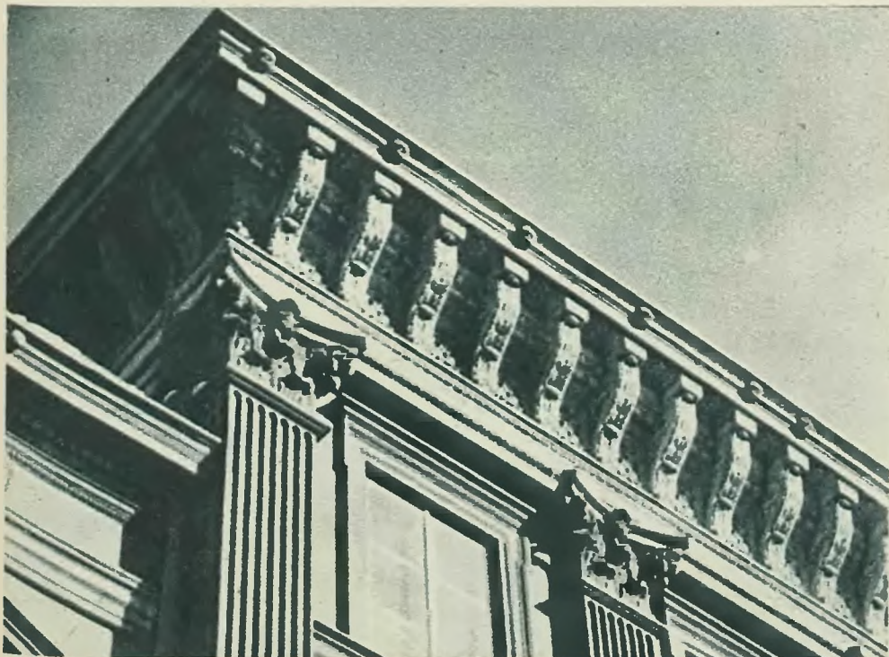
Gzym- sy wieńczący ze wspornikami na elewacji gmachu Instytutu Geograficznego
