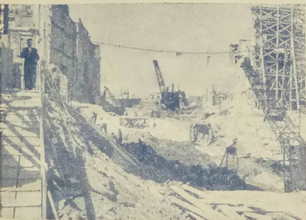
Po dokładnej inwentaryzacji rozebrano resztki kilku zburzonych zabytkowych kamieniczek, stojących na csi tunelu. Po zakończeniu budowy tunelu budynki te zostaną zrekonstruowane.
