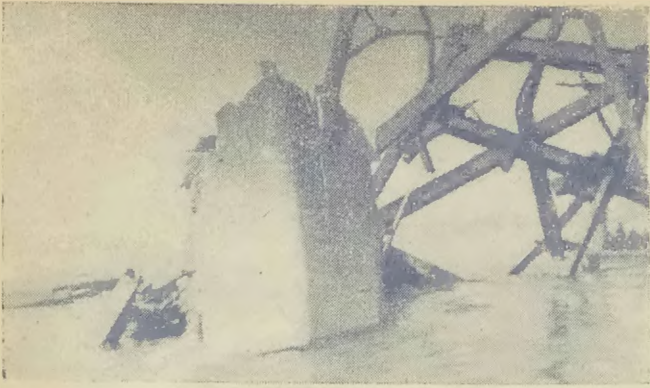
Usunięto 65% starej konstrukcji mostu Kierbedzia.
