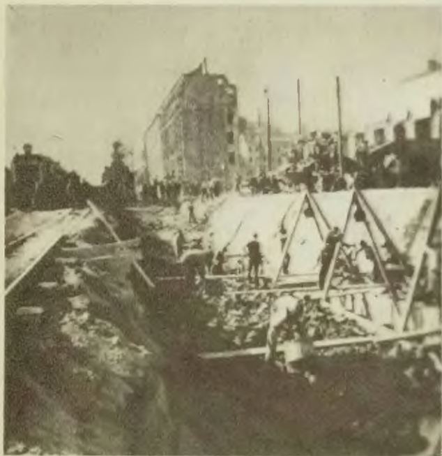
Rozbudowa tunelu linii średnicowej - szalowanie wykopu
