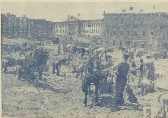
Od wylotu tunelu do ul. Hipotecznej wykonano wykop w 60%.
