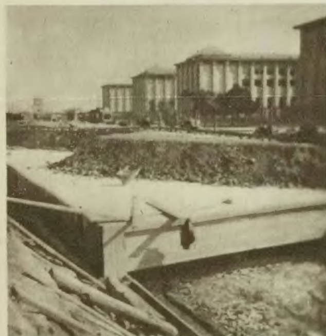
Rozbudowa tunelu linii średnicowej - tunel gotowy
