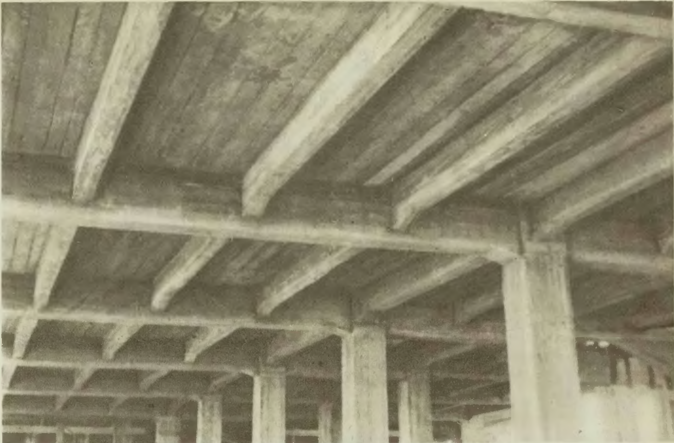
Betonowa konstrukcja i strop Państwowych Zakładów Hodowli Roślin na Służewcu.
