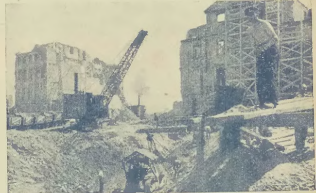
Wykonano w 100% I etap robót ziemnych na odcinku tunelu.
