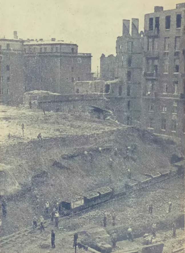
Ogólny widok pracy Służby Polsce przy obniżaniu wiaduktu Pancera.
