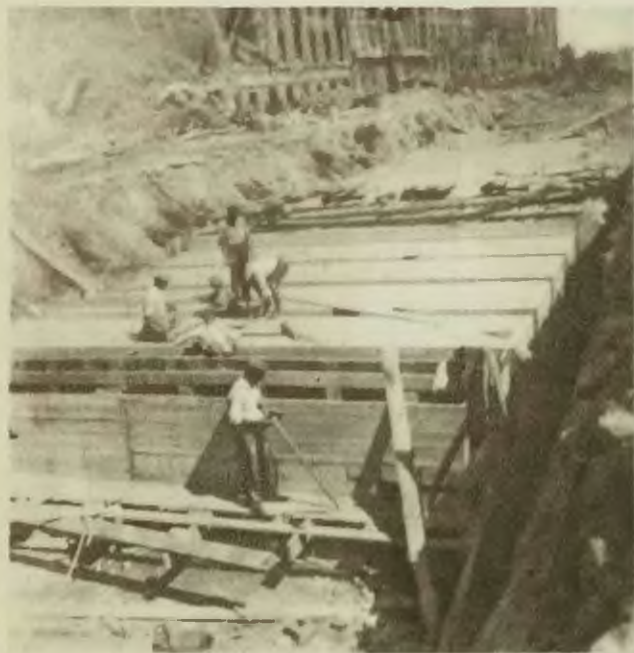
Rozbudowa tunelu linii średnicowej - betonowanie ścian i stropów
