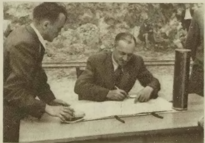
Minister Odbudowy prof. M. Kaczorowski składa podpis pod aktem erekcyjnym Domu Słowa Polskiego.
