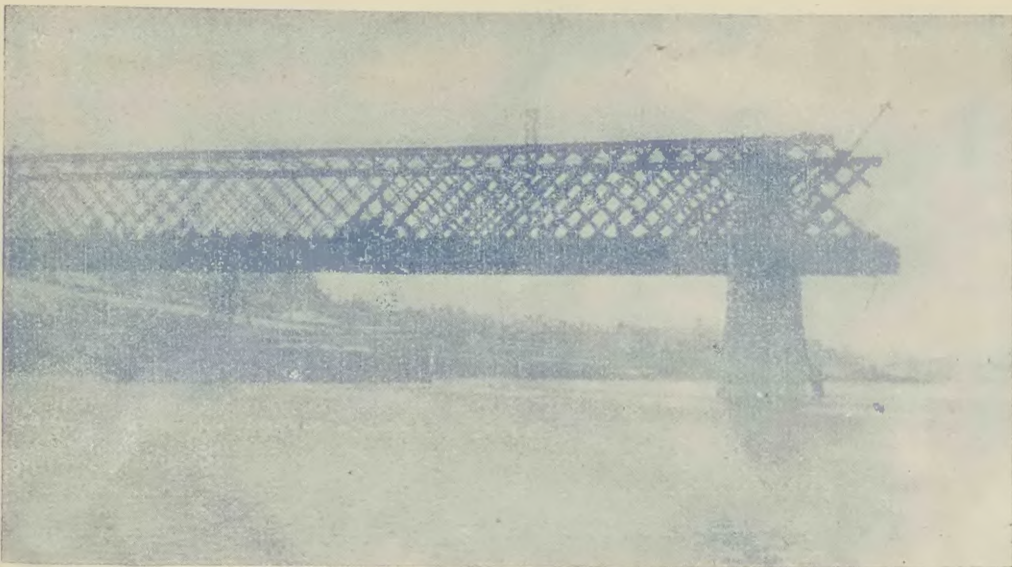
Z zatłoczonego mostu Poniatowskiego, z przeladowanego „pontoniaka“ patrzyli zmartwieni warszawiacy na ponuro sterczącą konstrukcję zburzonego mostu Kierbedzia. — Takby się nam przydał drugi stały most!
