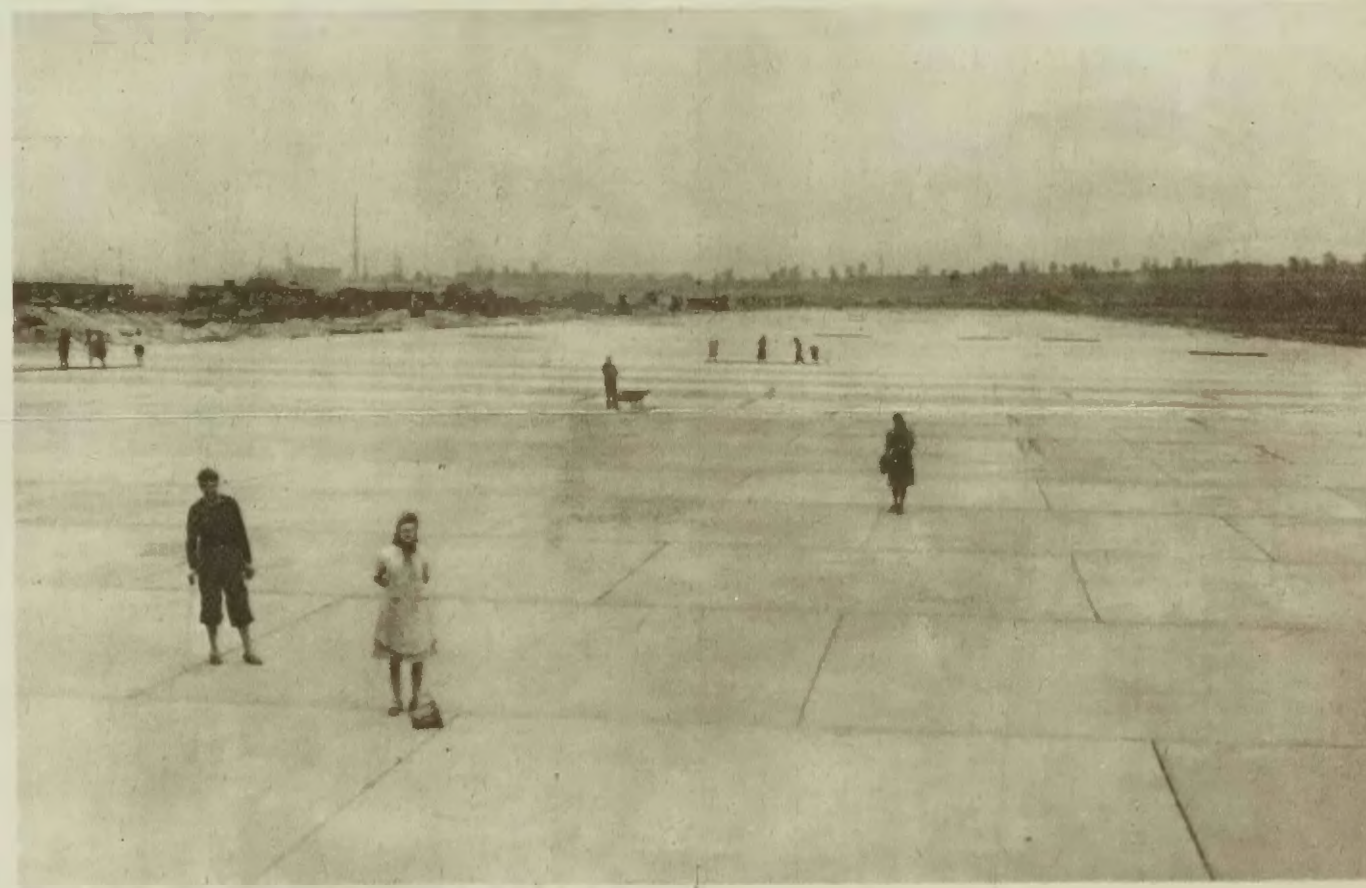
Betonowe pole startowe na Okęciu.
