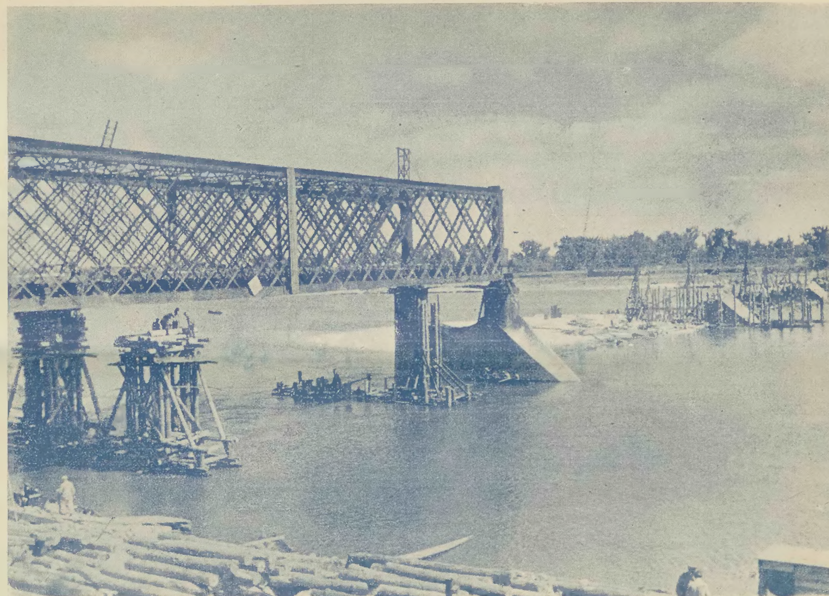
Znika na zawsze stara, kratowa konstrukcja mostu Kierbedzia.
