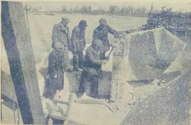
Wykonano w 100% prace rozbiórkowe przy filarach i przyczółkach mostu Kierbedzia (rozebrano 2.400 m 3 kamienia).
