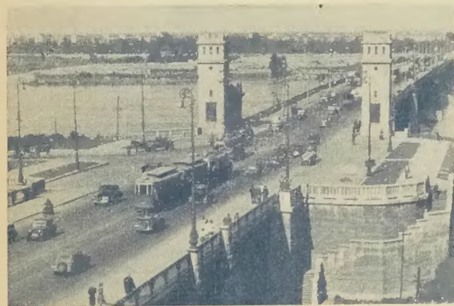
W roku 1946 odbudowano most Poniatowskiego.
